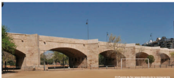
(C) Puente de Serranos después de la restauración
