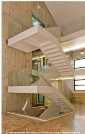
(C) Nueva escalera del Servicio de Tráfico en la antigua Nave de Máquinas
