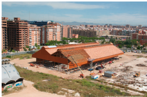
(A) Proceso de sustitución de la cubierta
