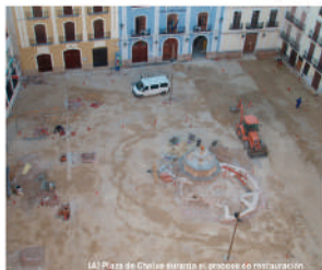
(A) Plaza de Chelva durante el proceso de restauración
