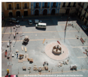
(A) Plaza de Chelva durante el proceso de restauración
