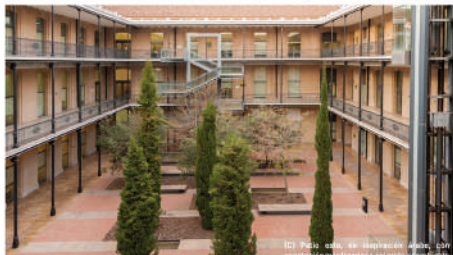
(C) Patio sala de exposición antes de la restauración
