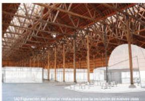
(A) Espaciado del interior tras sustituir la cubierta por aluminio
