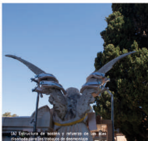
(A) Estructura de sosten y refuerzo de las alas protodada para los trabajos de mantenimiento
