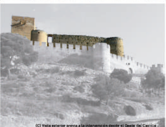
(C) Vista exterior previa a la intervención desde el Oeste del Castillo
