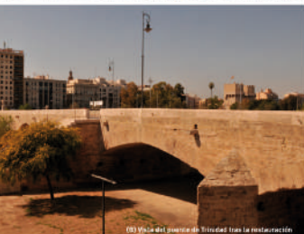
(B) Vista del puente de Trinidad tras la restauración
